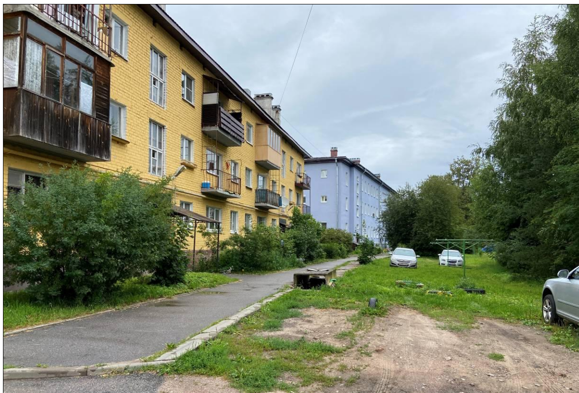
19. Проезд вдоль домов №№ 4 и 3 по улице Спорта. Вид на северо-восток от дома № 4 по улице Спорта . 18.07.23 г.
