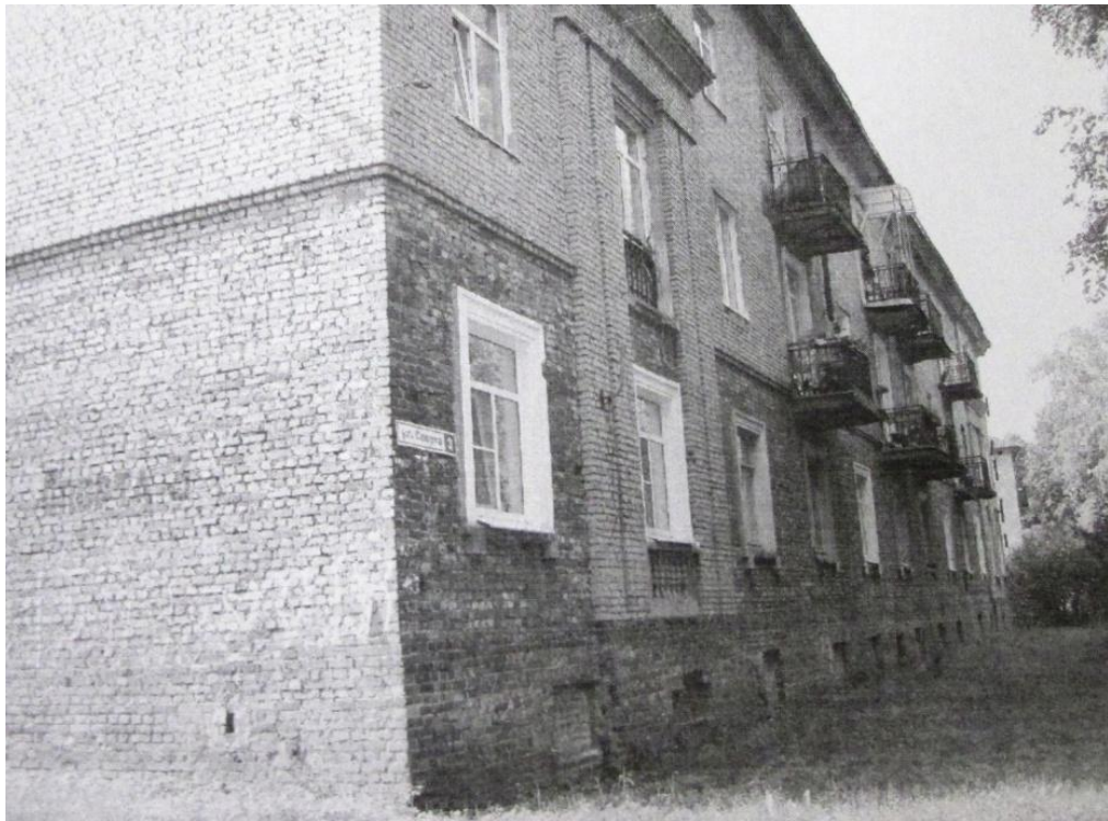
Ил. 9. Архив Комитета по сохранению культурного наследия Ленинградской области. Поселок имени Морозова. Дом, где в 1943 году находился штаб 3-й Понтонно-мостовой бригады РГК. Фото 2011 г.
