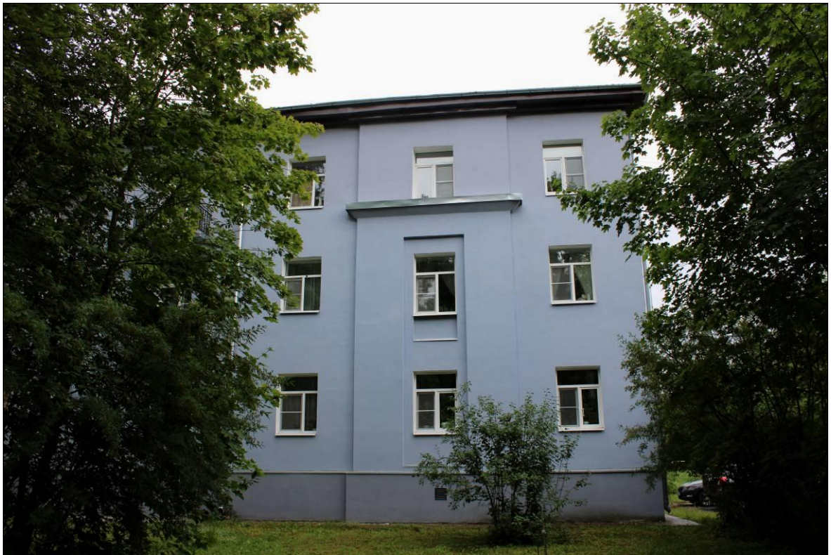
5. Объект культурного наследия регионального значения «Дом, где в 1943 г. находился штаб бригады воинов-понтонеров, наводивших переправы через Неву, после прорыва блокады Ленинграда. На доме установлена памятная доска». Южная часть лицевого фасада. Вид на юго-восток с улицы Спорта. 18.07.23 г.
