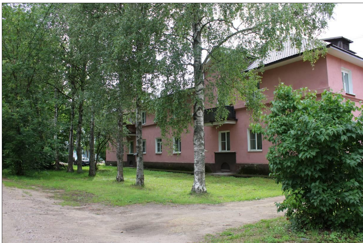
42. Улица Новая, дом 1. Вид на юго-запад от улицы Новой. 18.07.23 г.
