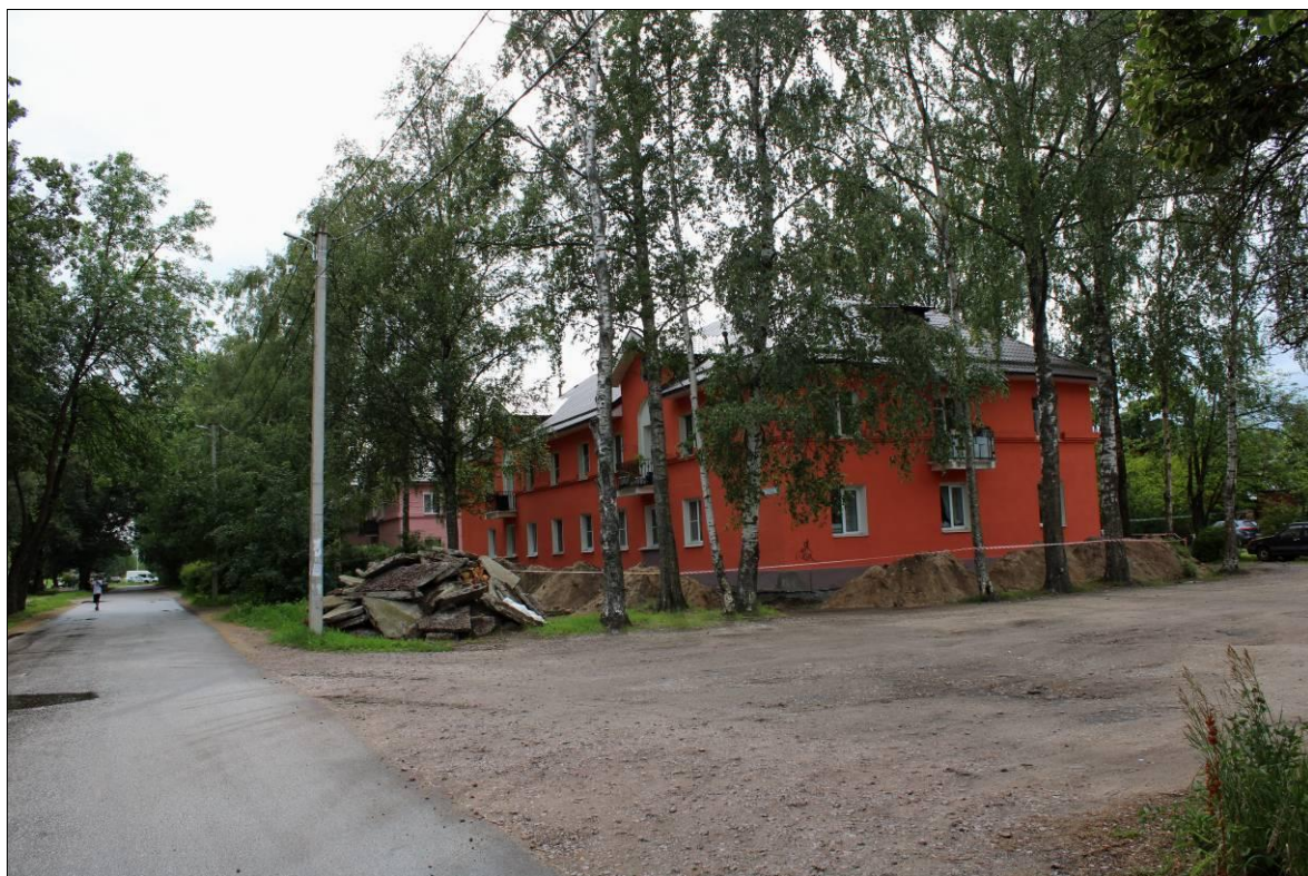
41. Улица Новая, дом 2. Вид на юго-запад от улицы Новой. 18.07.23 г.
