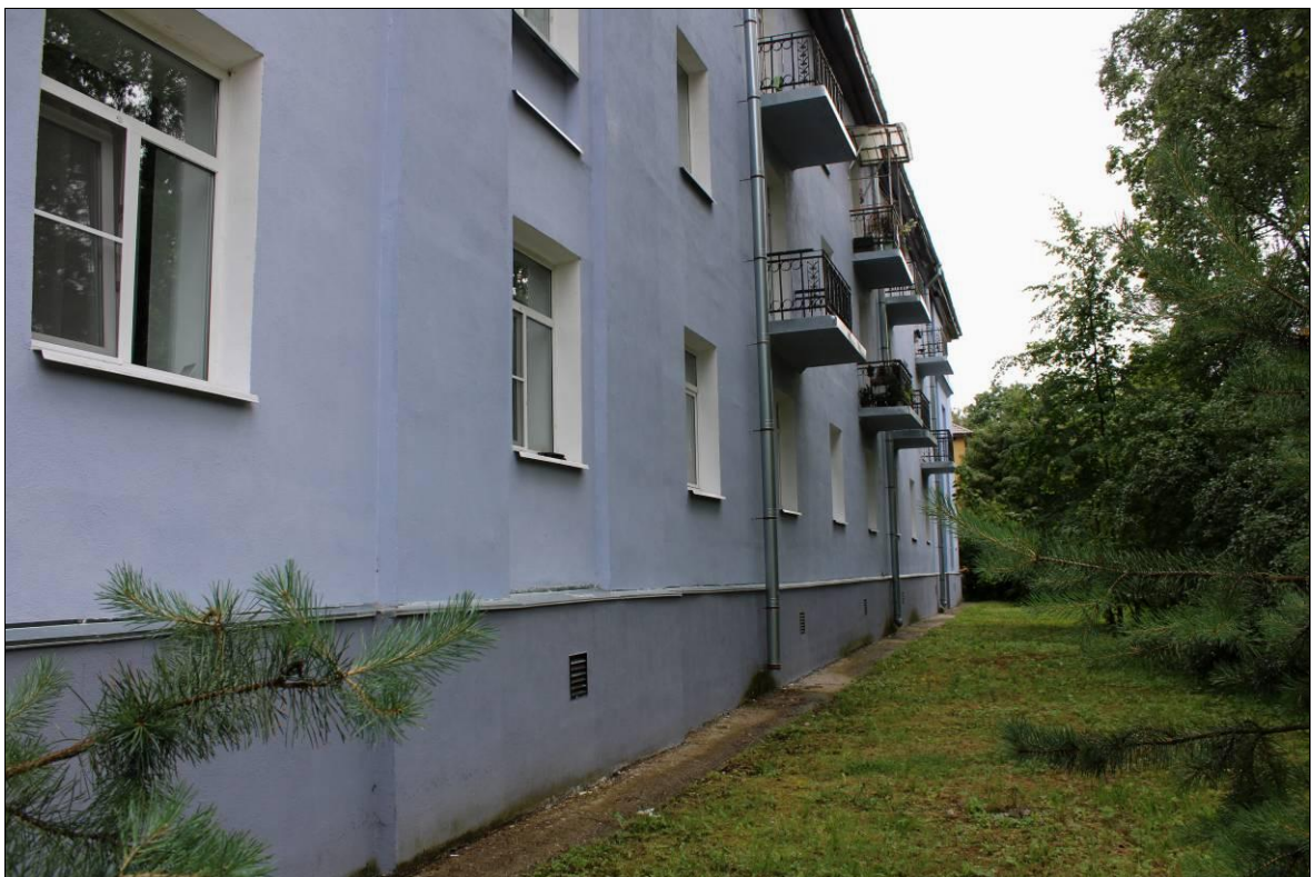
6. Объект культурного наследия регионального значения «Дом, где в 1943 г. находился штаб бригады воинов-понтонеров, наводивших переправы через Неву, после прорыва блокады Ленинграда. На доме установлена памятная доска». Лицевой фасад. Вид на юго-запад. 18.07.23 г.
